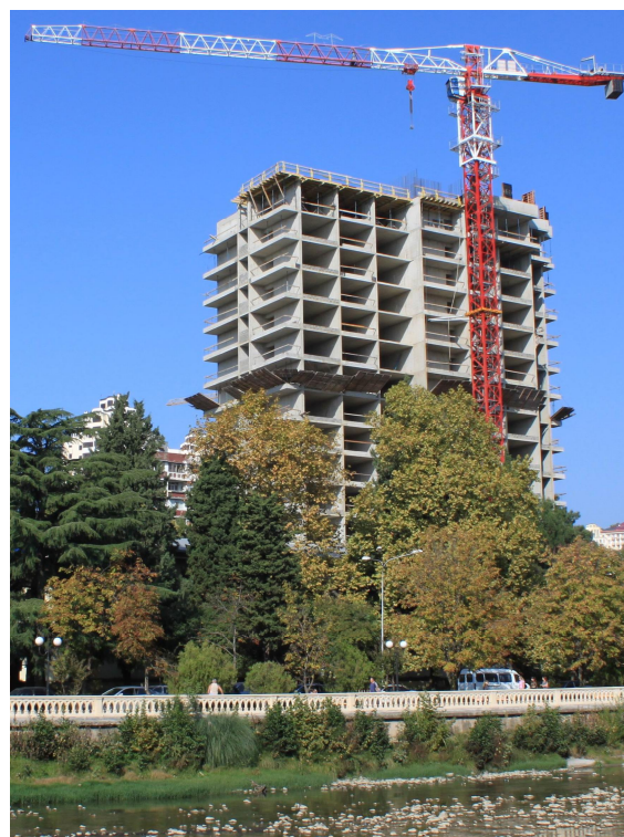
Рисунок 5 - Общий вид здания на период окончания возведения несущих конструкций
