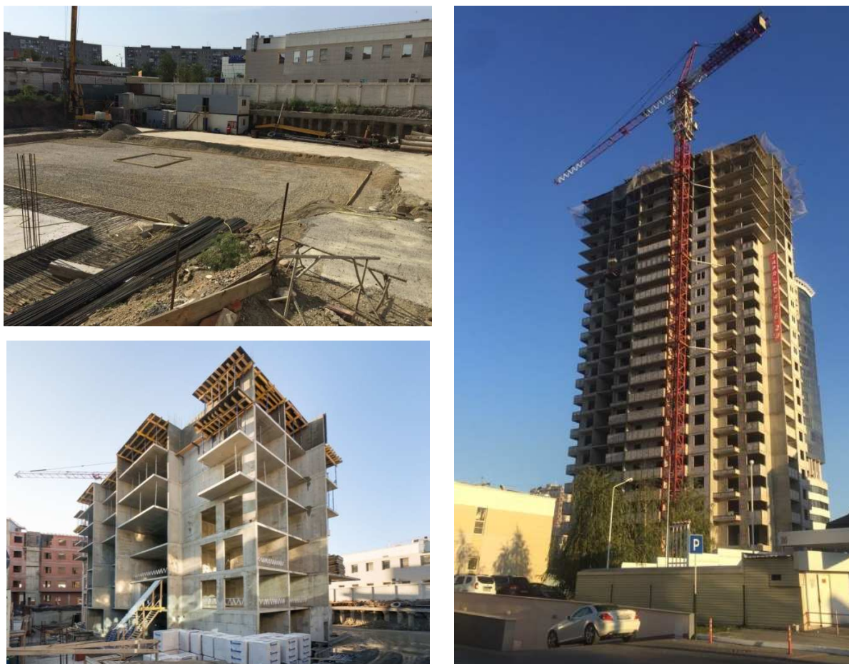
Рисунок 27 – Этапы возведения 25-этажного жилого дома на вертикально армированном основании
