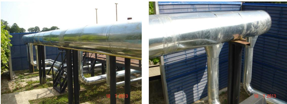
Рисунок 1 - Трубопровод со звукоизолирующим покрытием
