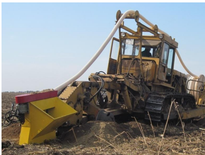
Рисунок 2 – Реконструкция дренажа ЗАО «Краснокутское»
